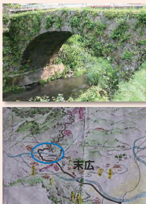
上：車橋 下：末広から、府内(現大分市)へと通じる主要な街道1であった。
